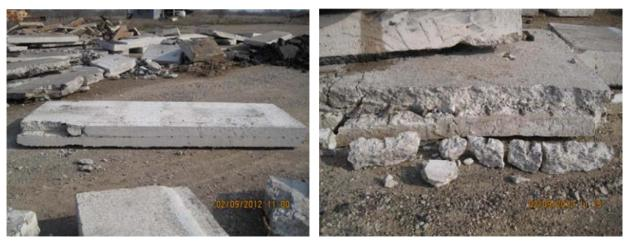
(c) Delamination (d) Delamination and distress Figure 2.12 Paris, IH 30
