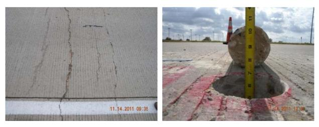
(c) Narrow cracks (d) Horizontal crack Figure 2.9 Atlanta, SL 151
